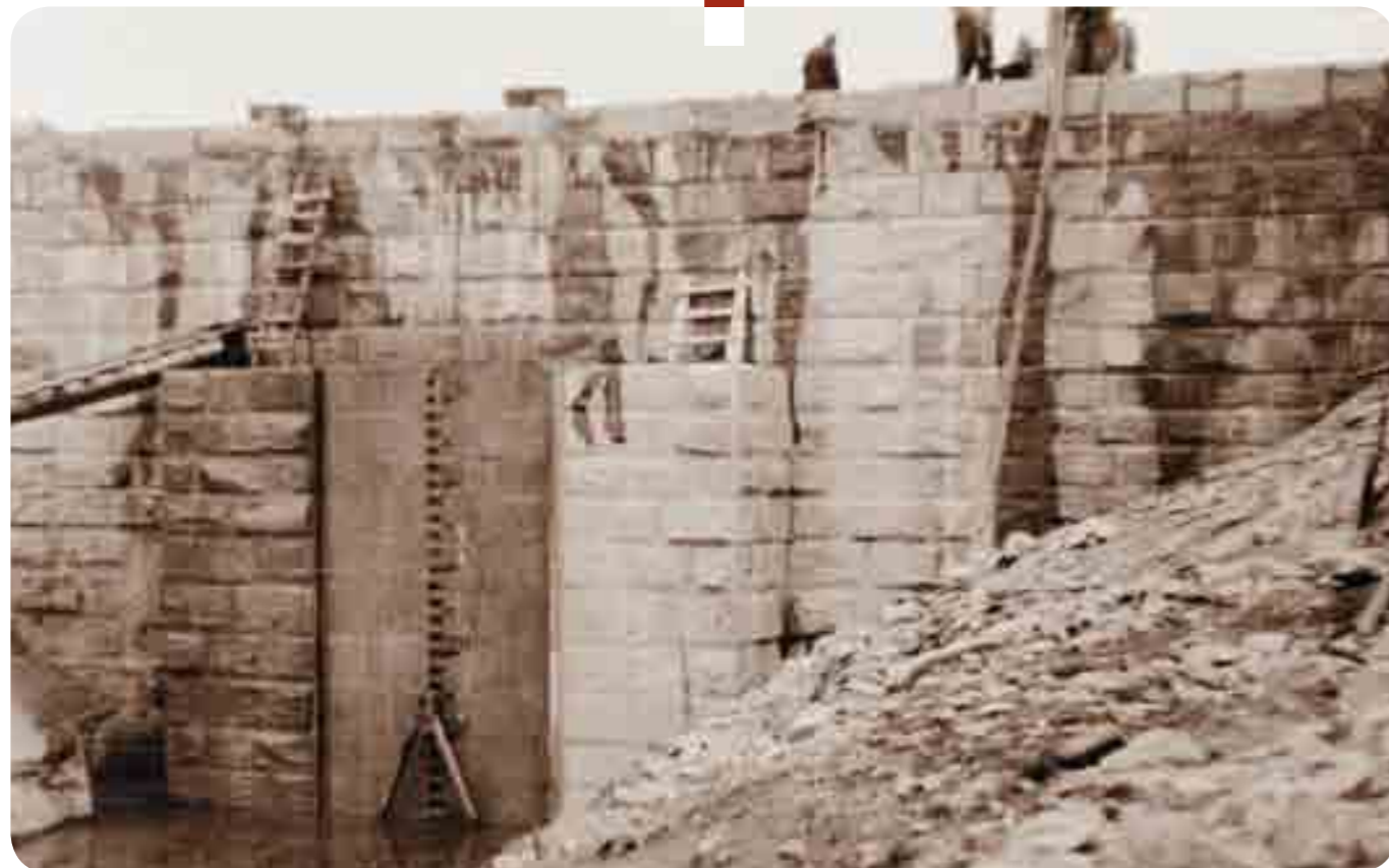
Realizzazione dello scarico di fondo della diga del Serrù
