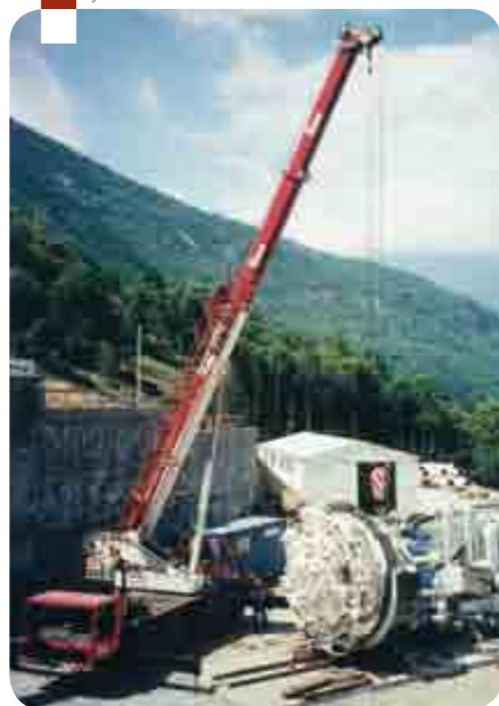
Operazioni di montaggio della fresa a Pont Ventoux-Susa
