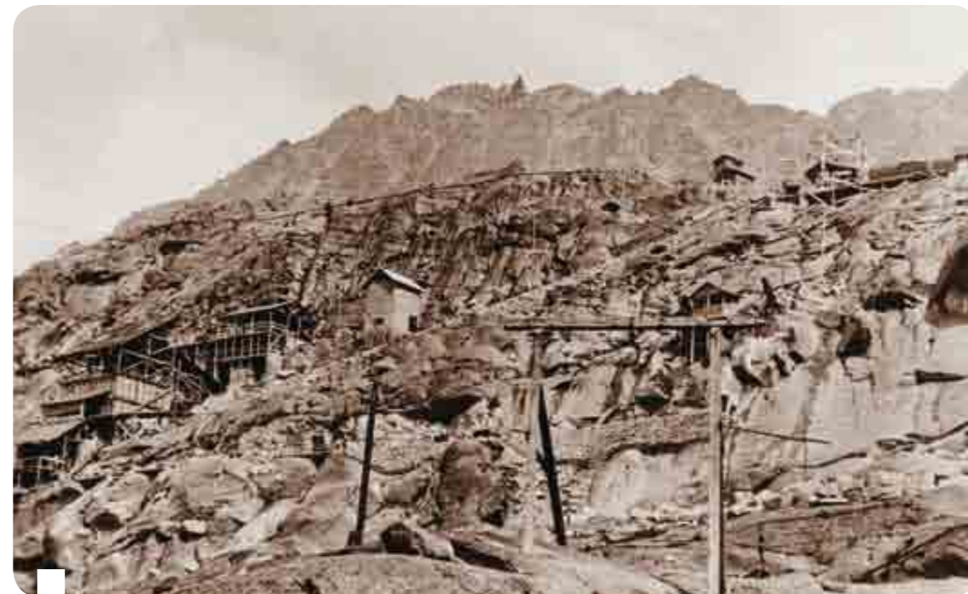
Impianto di frantumazione, betonaggio e stazione Blondin nel cantiere della diga Valsoera
