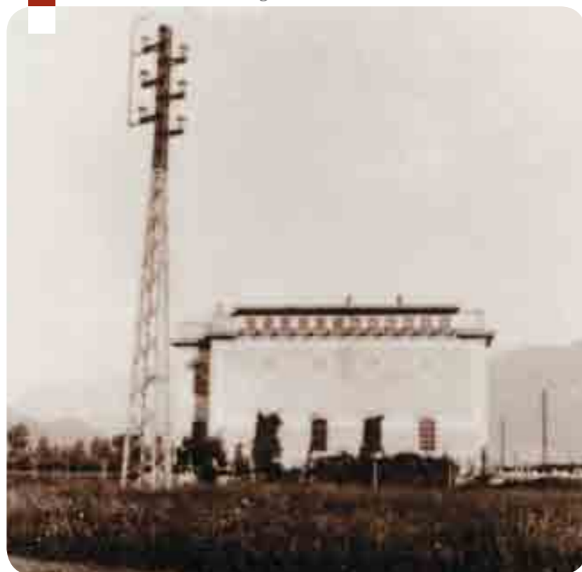
La cabina elettrica di Borgone di Susa
