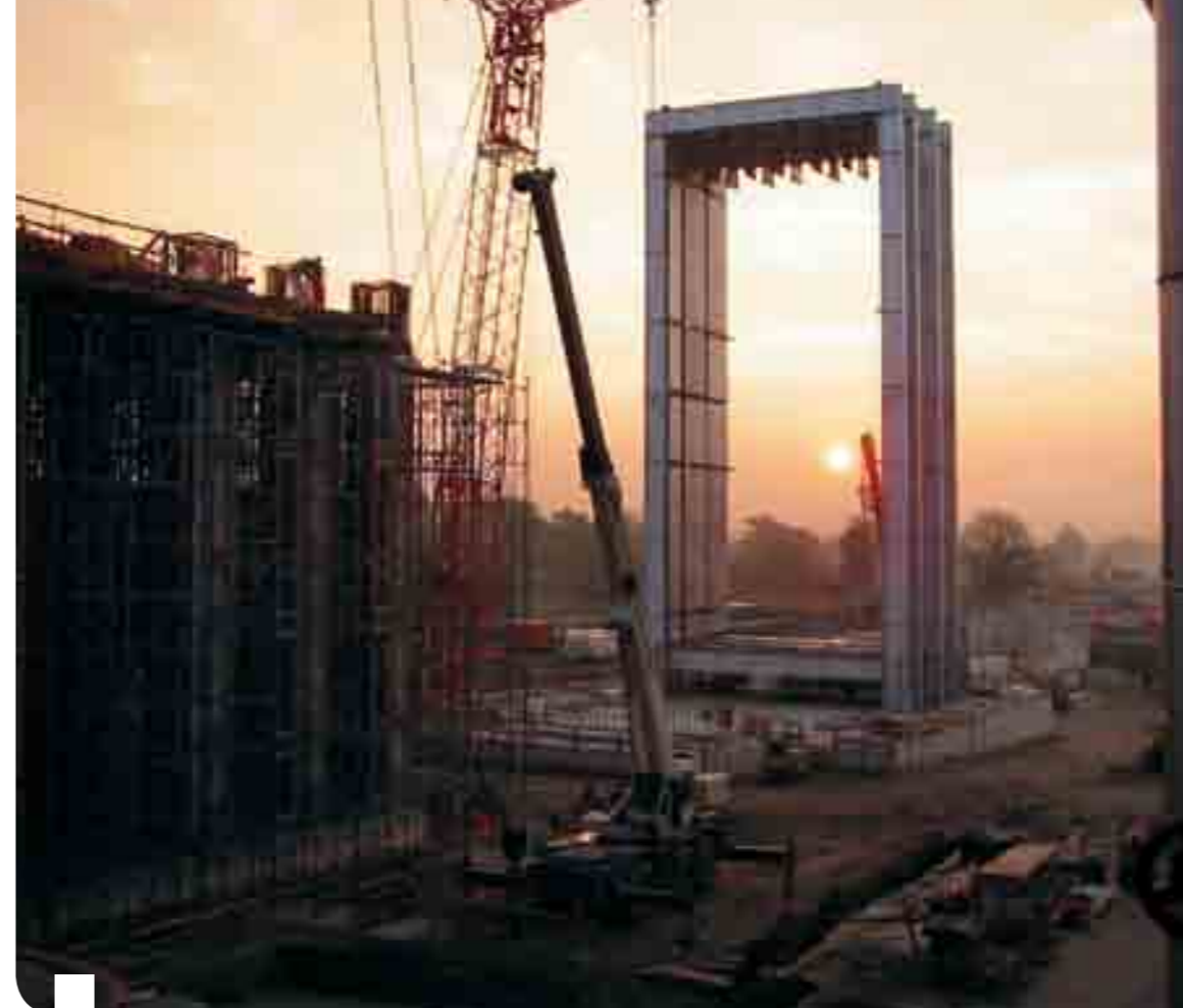
Due fasi di montaggio del 3° GT
