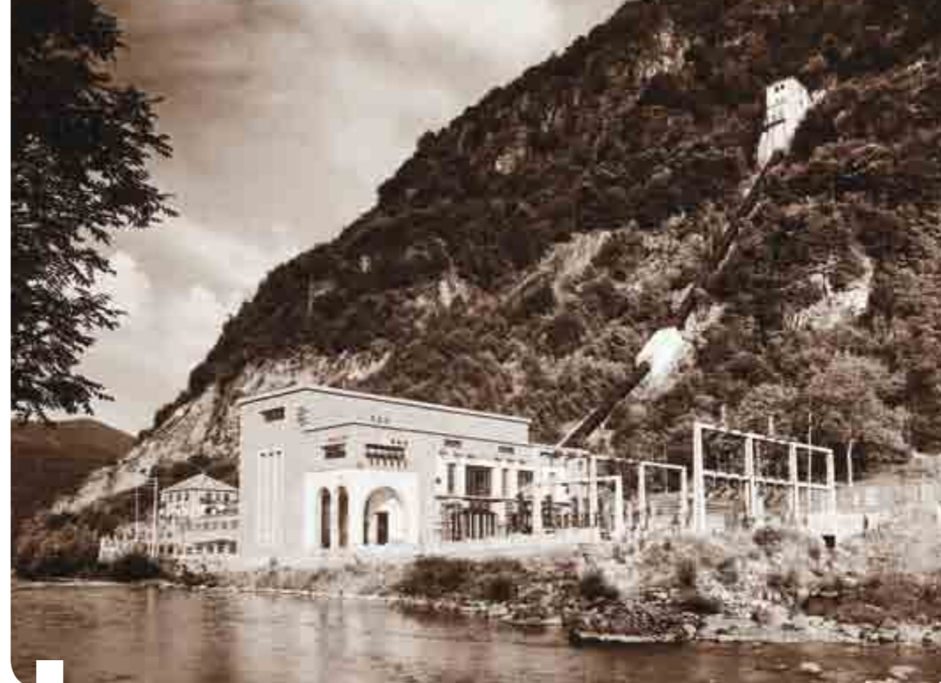
La centrale idroelettrica di Pont Canavese
