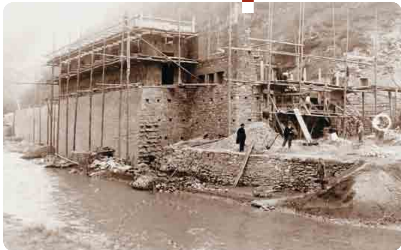
Fase della costruzione della centrale di Susa
