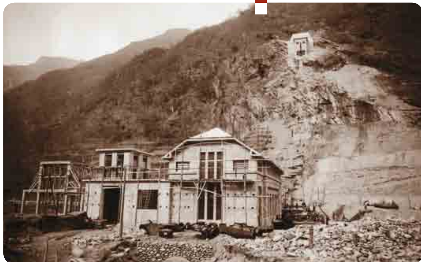
La costruzione della centrale di Bardonetto
