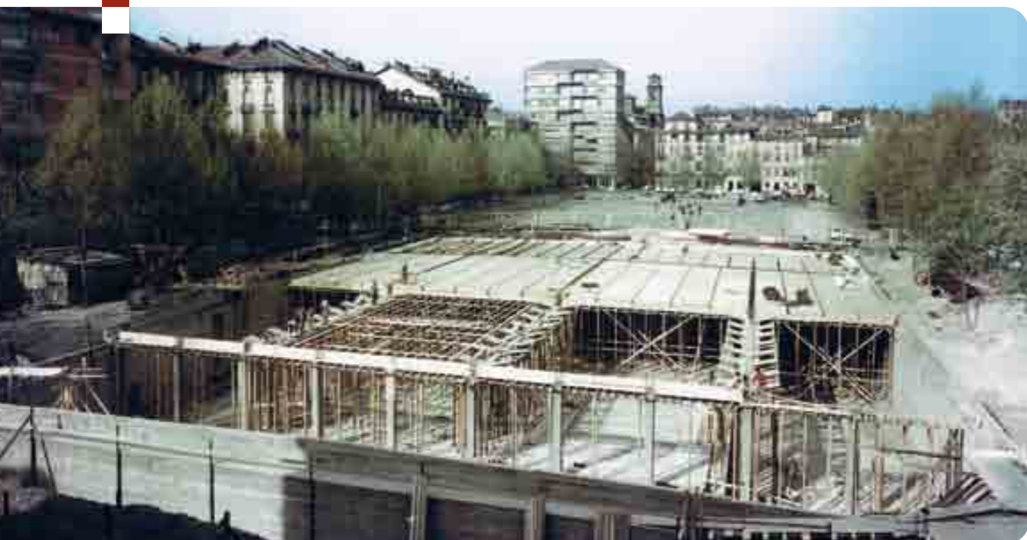
Costruzione della cabina Cittadella
