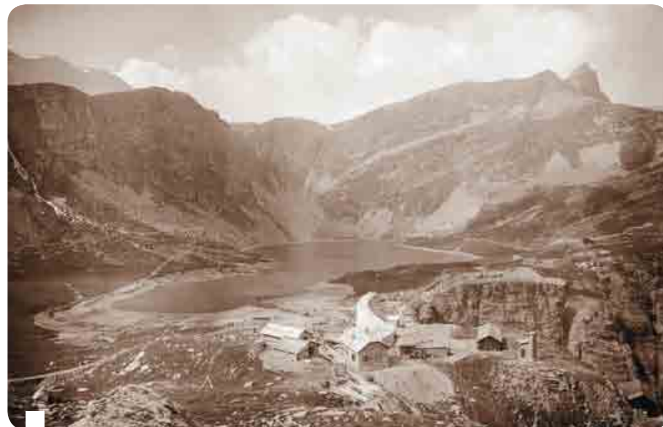
Procedono i lavori per la costruzione della diga del lago Agnel
