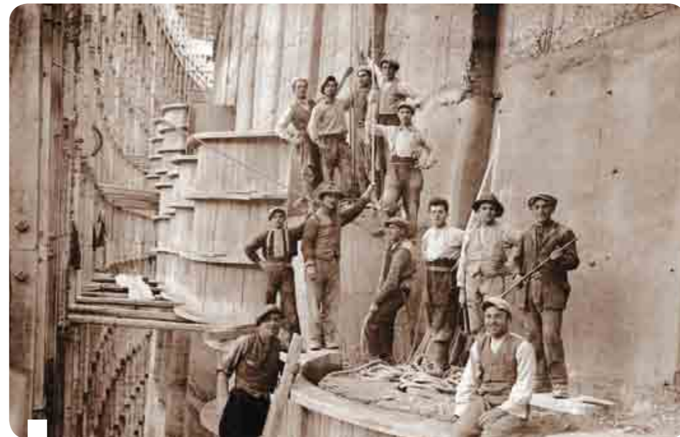
Un gruppo di operai nel corso della costruzione del paramento della diga di Ceresole
