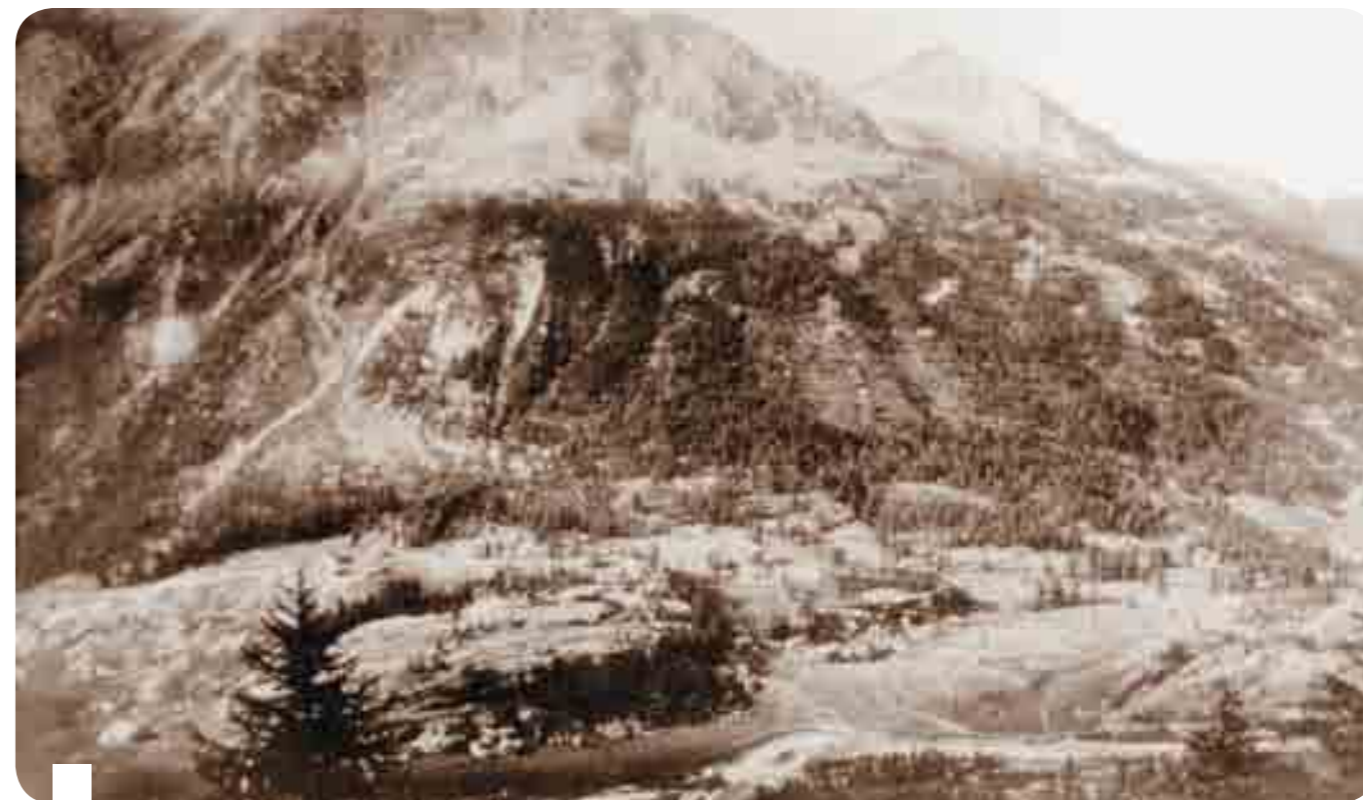
Veduta della piana di Ceresole Reale prima della realizzazione della diga
