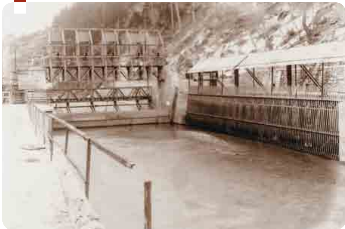
L'opera di presa di Serre la Voute
