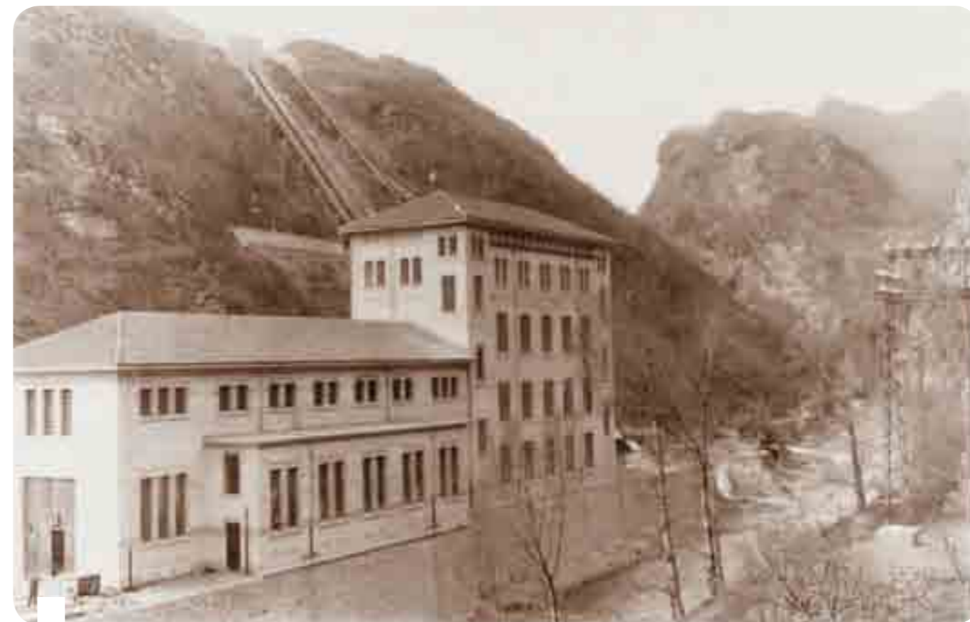
Veduta della centrale di Susa
