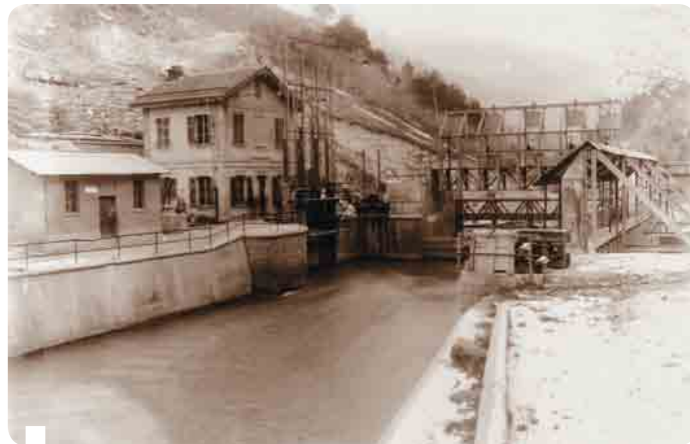
L'opera di presa di Serre la Voute
