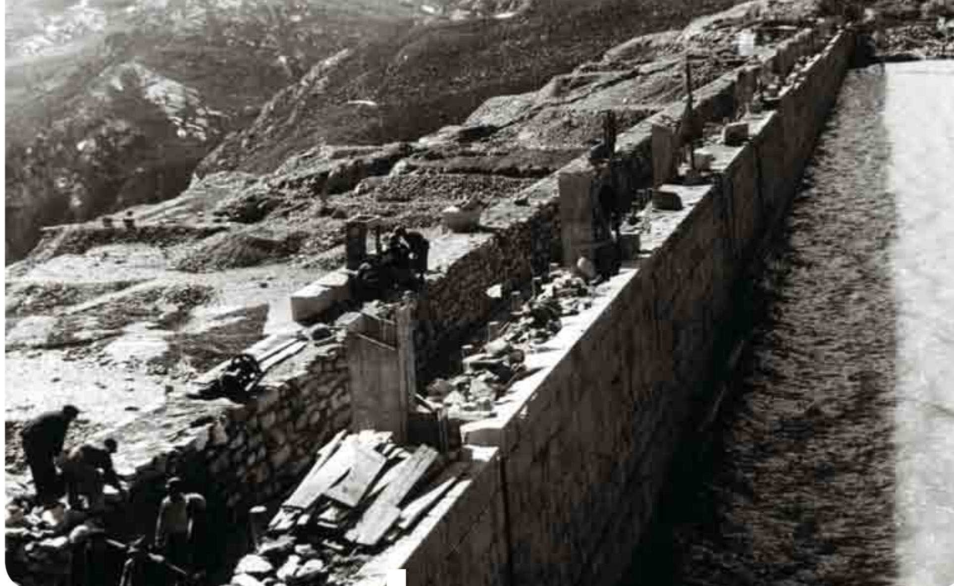
Lavori alla diga del lago Serrù
