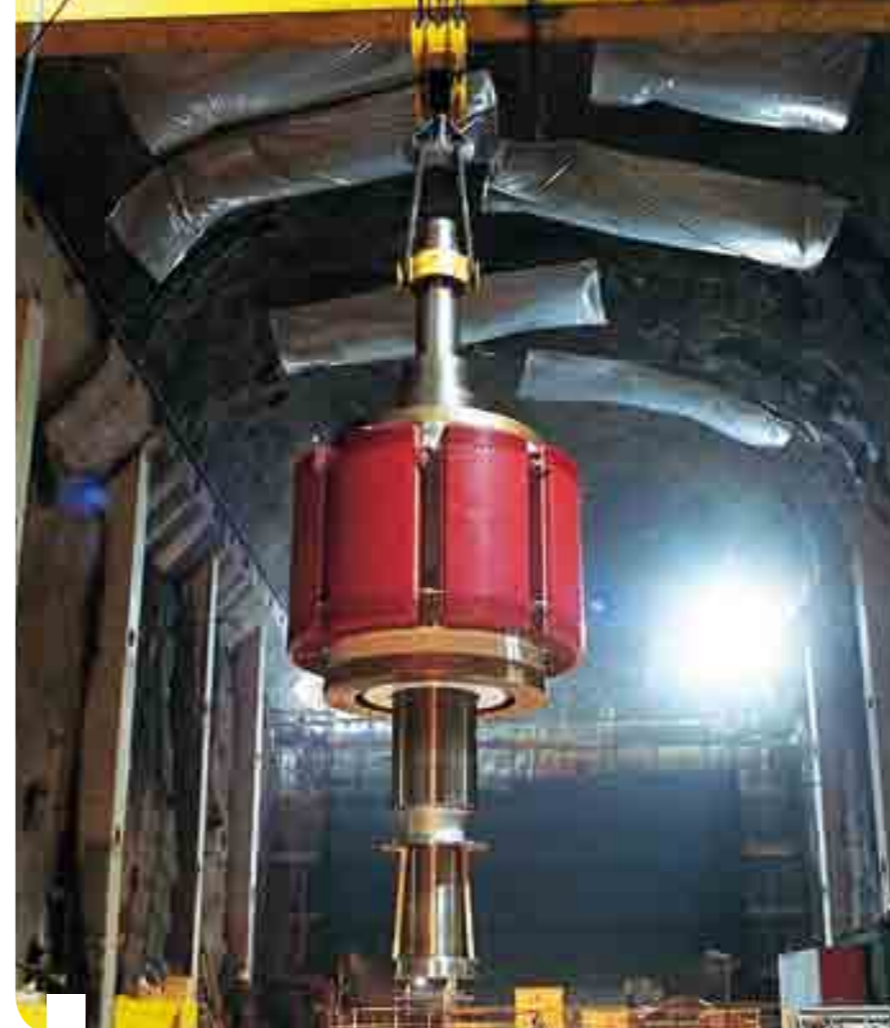
Pont Ventoux-Susa: assemblaggio del rotore
