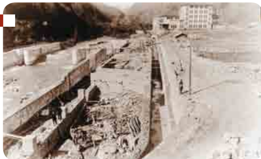
Costruzione delle vasche di decantazione presso l'opera di presa di Susa
