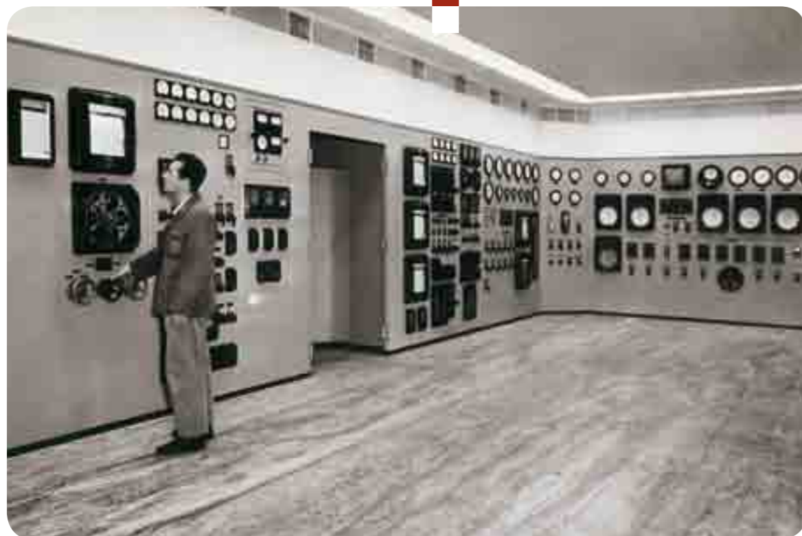
Sala controllo della centrale di Moncalieri
