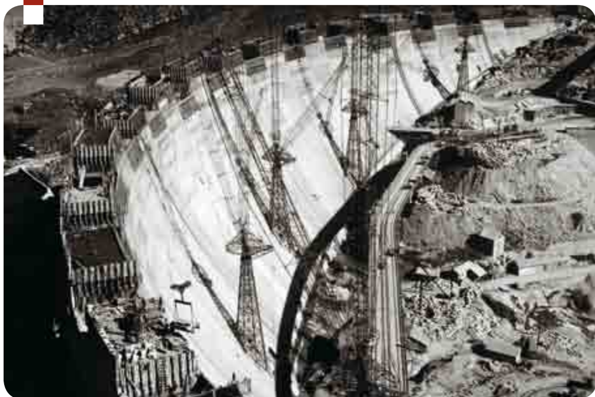
Costruzione della diga di Pian Telessio
