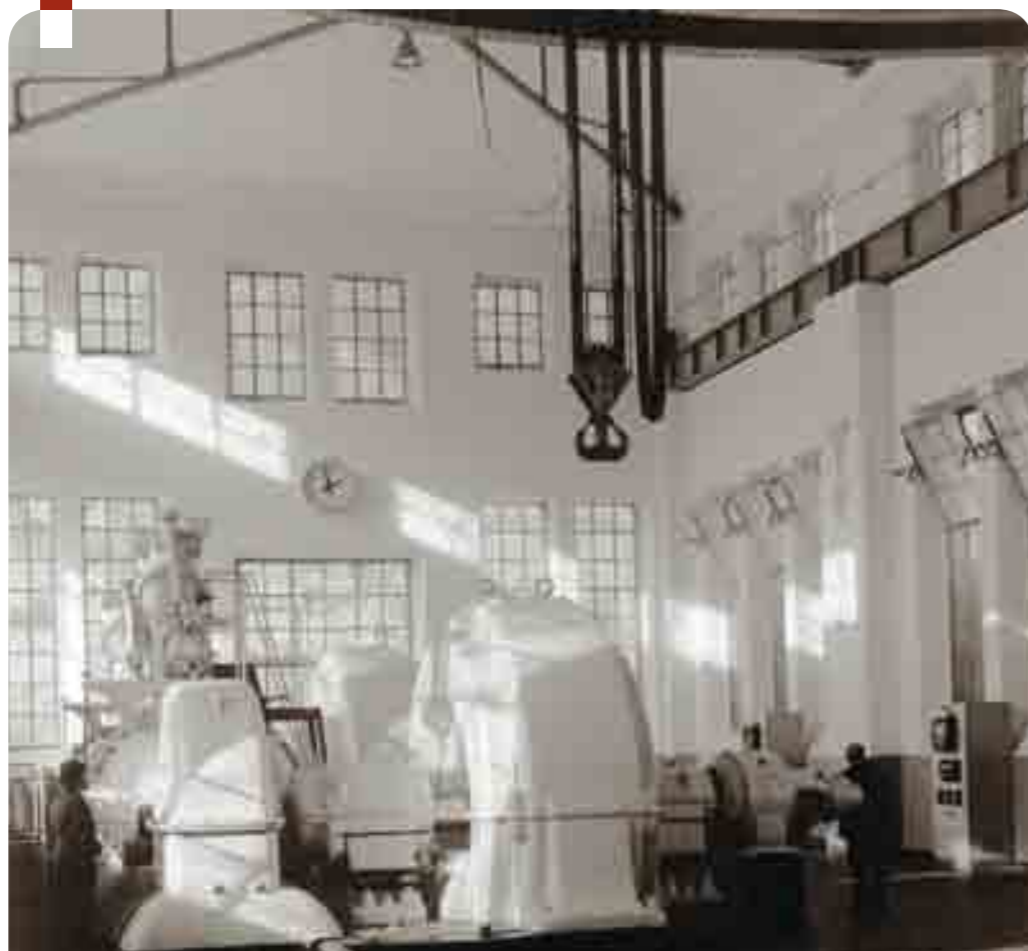
Interno della centrale di Chiomonte
