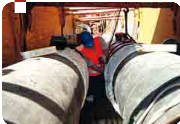
Posa della rete del teleriscaldamento
