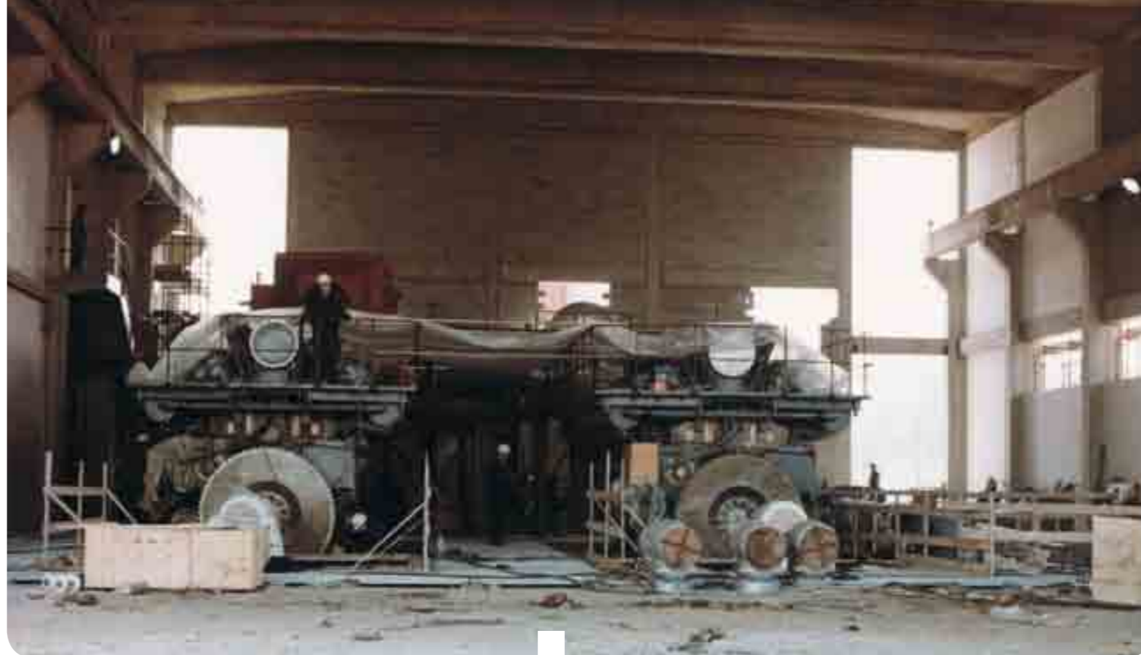
Installazione dei motori nella centrale Le Vallette
