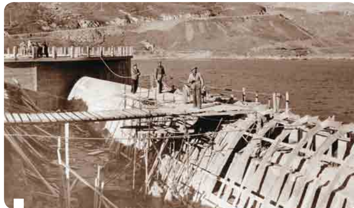
Due fasi della costruzione dello sfioratore del lago Agnel
