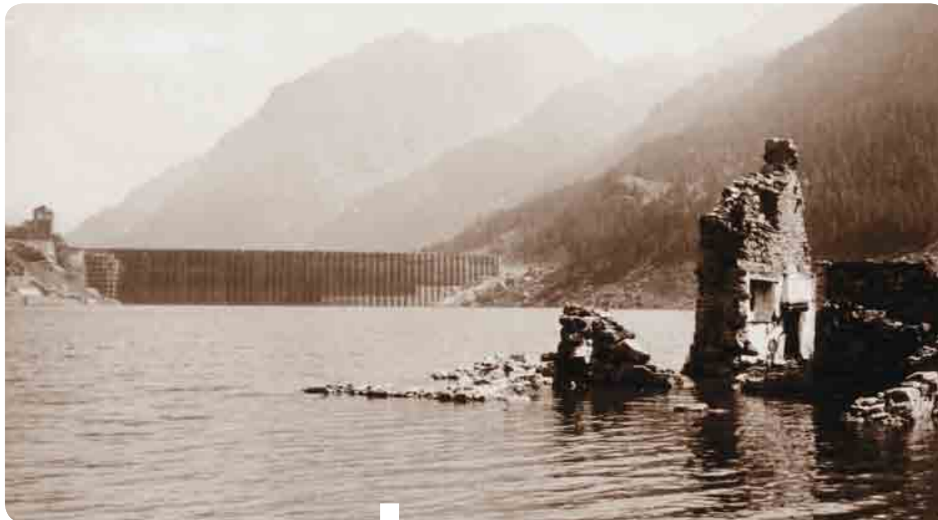
Una veduta suggestiva: dal lago di Ceresole al minimo livello riaffiorano alcune costruzioni
