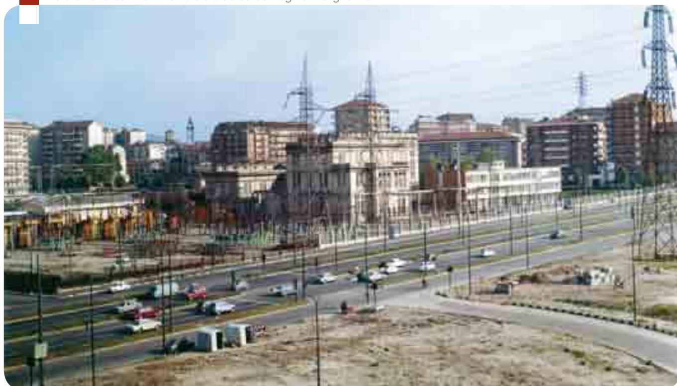
La stazione del Martinetto vista da corso Regina Margherita
