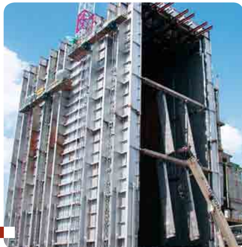
Ripotenziamento 2° GT: una delle fasi di costruzione
