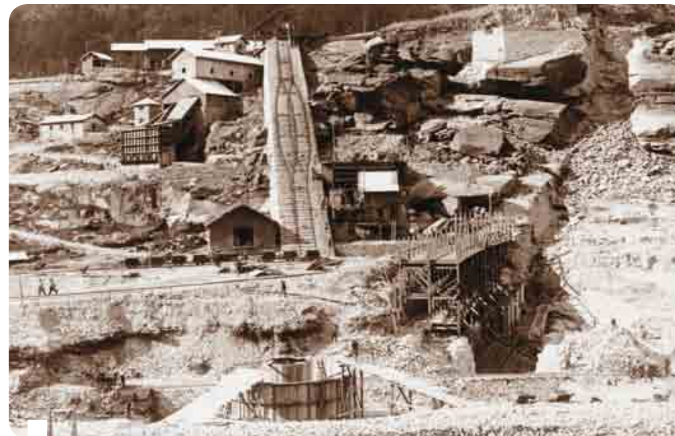
L'inizio dei lavori per la realizzazione della diga di Ceresole Reale
