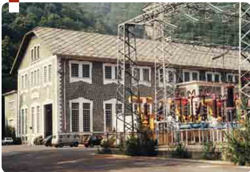
La centrale di Rosone
