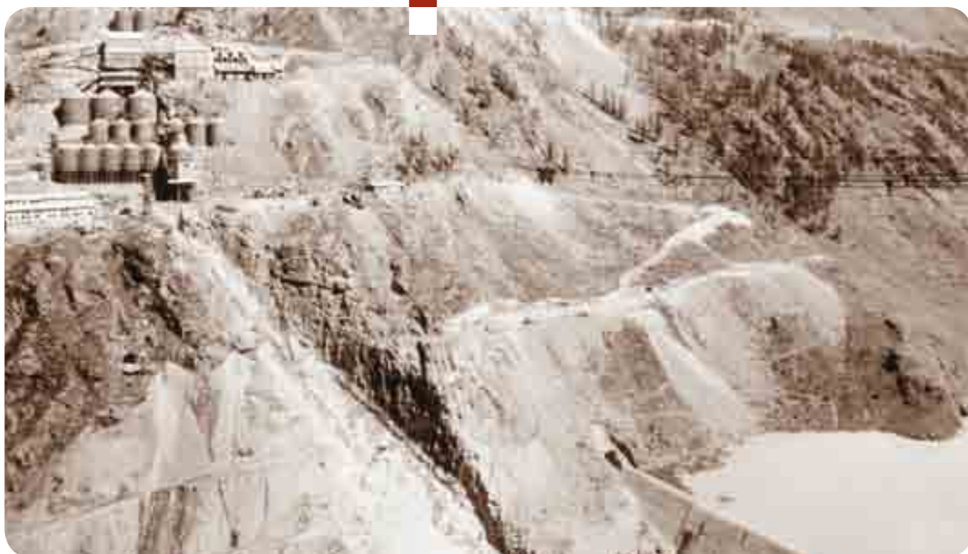
Costruzione dell'avandiga presso la diga di Place Moulin in Val d'Aosta: una realizzazione del Consorzio Elettrico del Buthier
