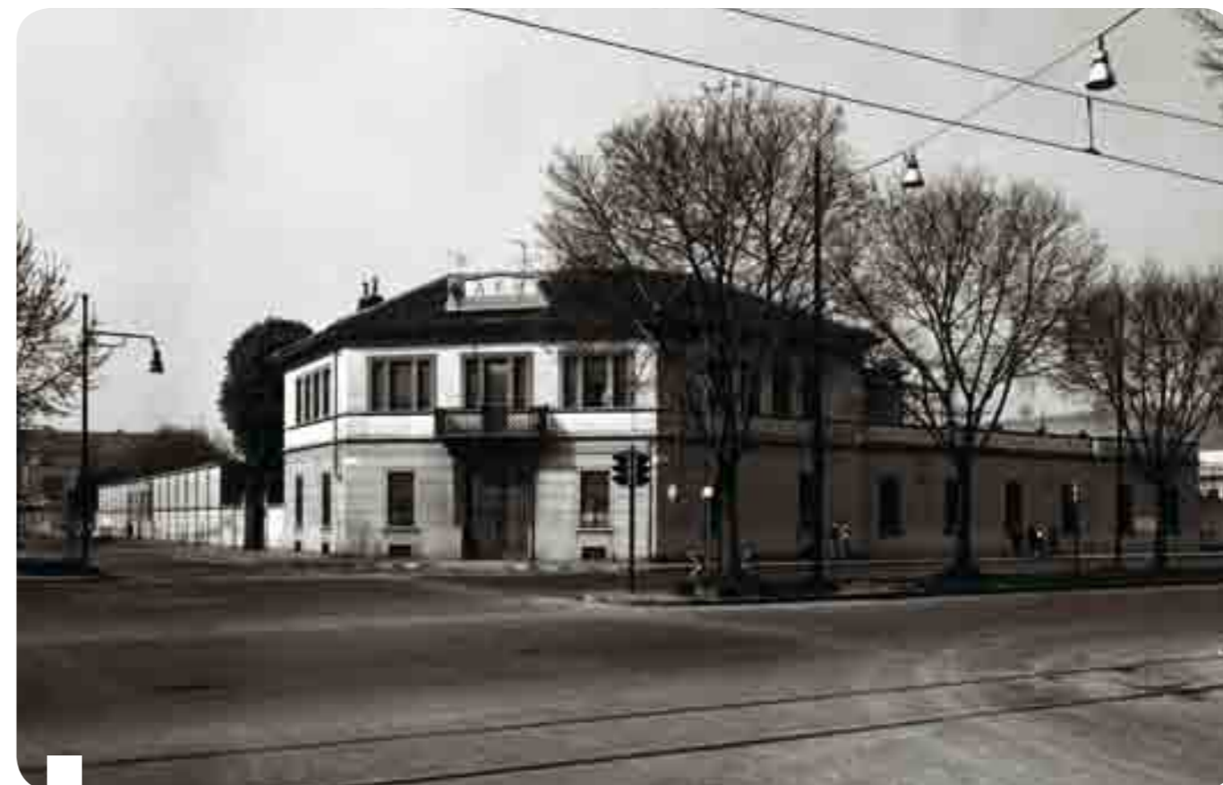
La casa del personale adiacente alla cabina Sebastopoli
