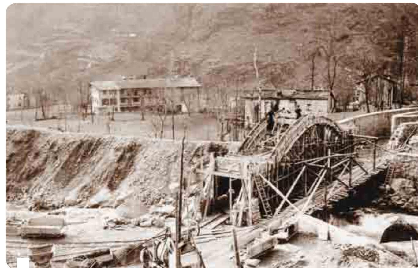
Una fase dei lavori del canale derivatore Rosone-Bardonetto
