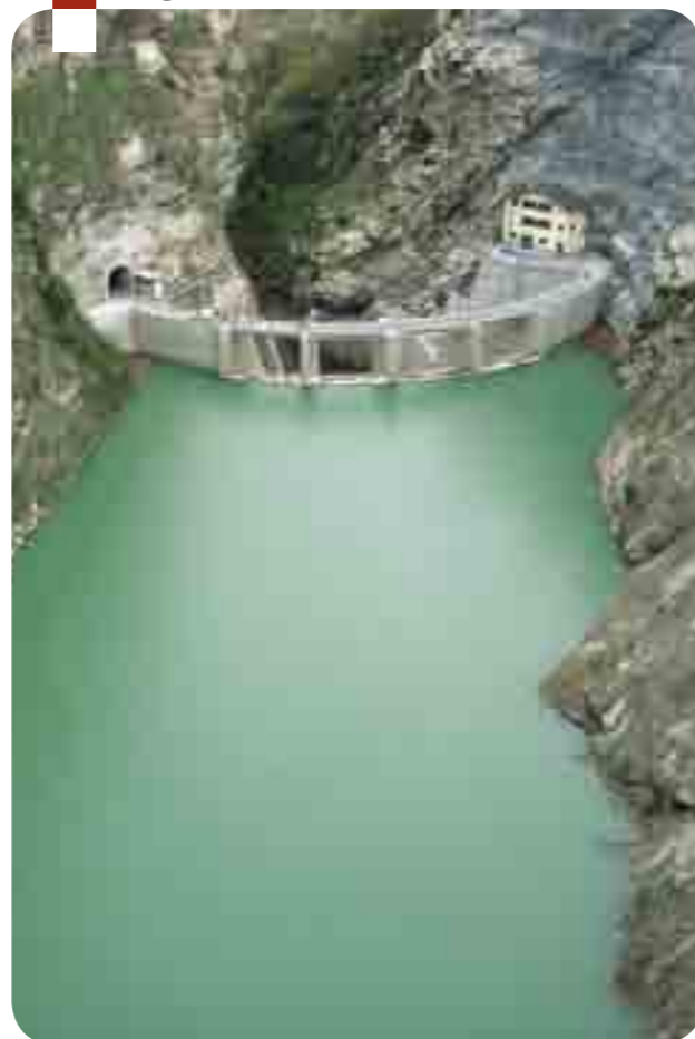
Impianto pont Ventoux-Susa: diga delle Gorge di Susa
