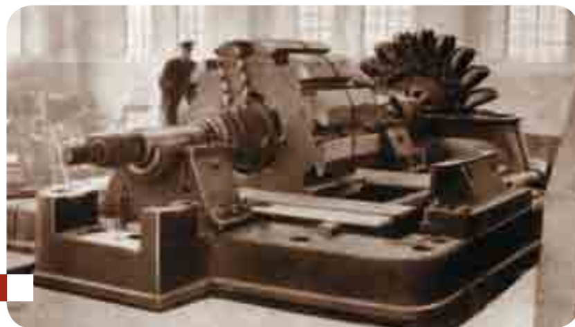
Il montaggio dei gruppi nella centrale di Rosone di Locana
