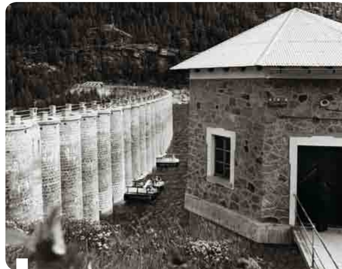
Lavori al paramento della diga di Ceresole
