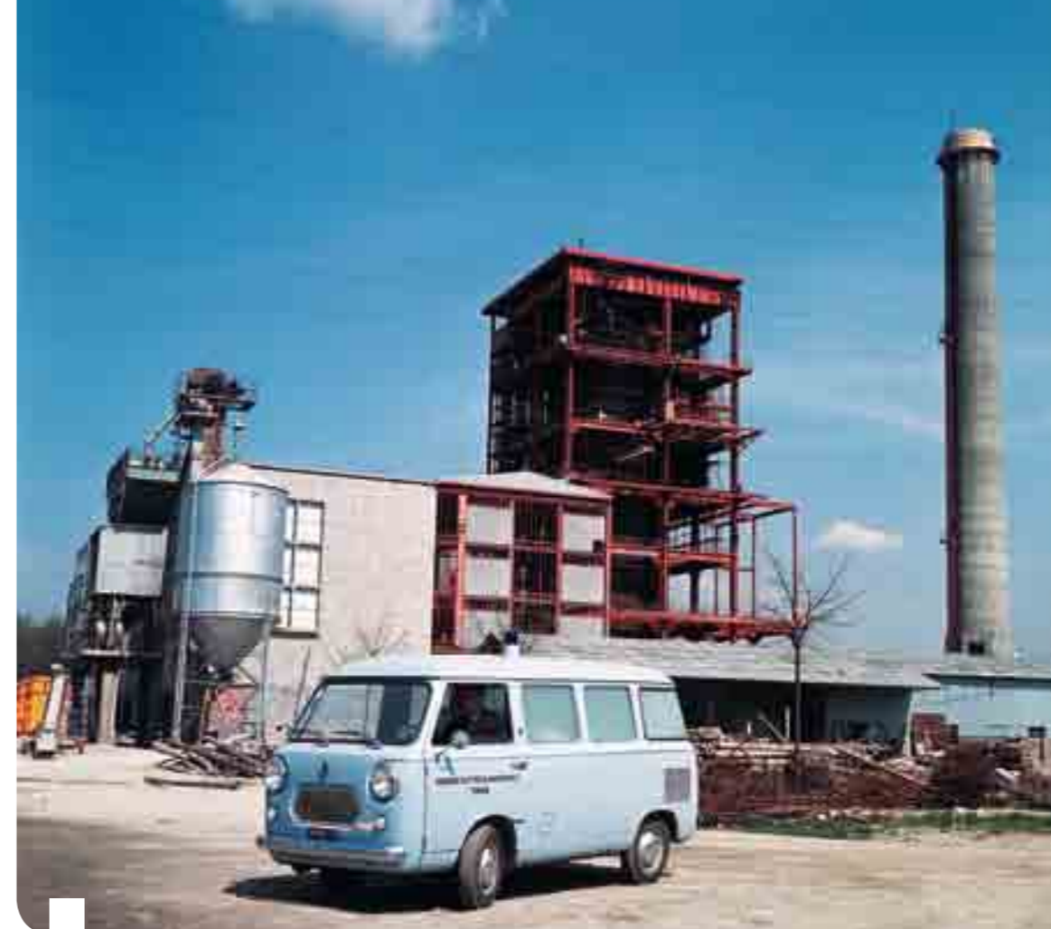
Costruzione della nuova sezione della centrale di Moncalieri
