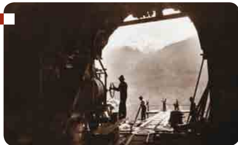
Lo scavo del canale di derivazione in galleria
