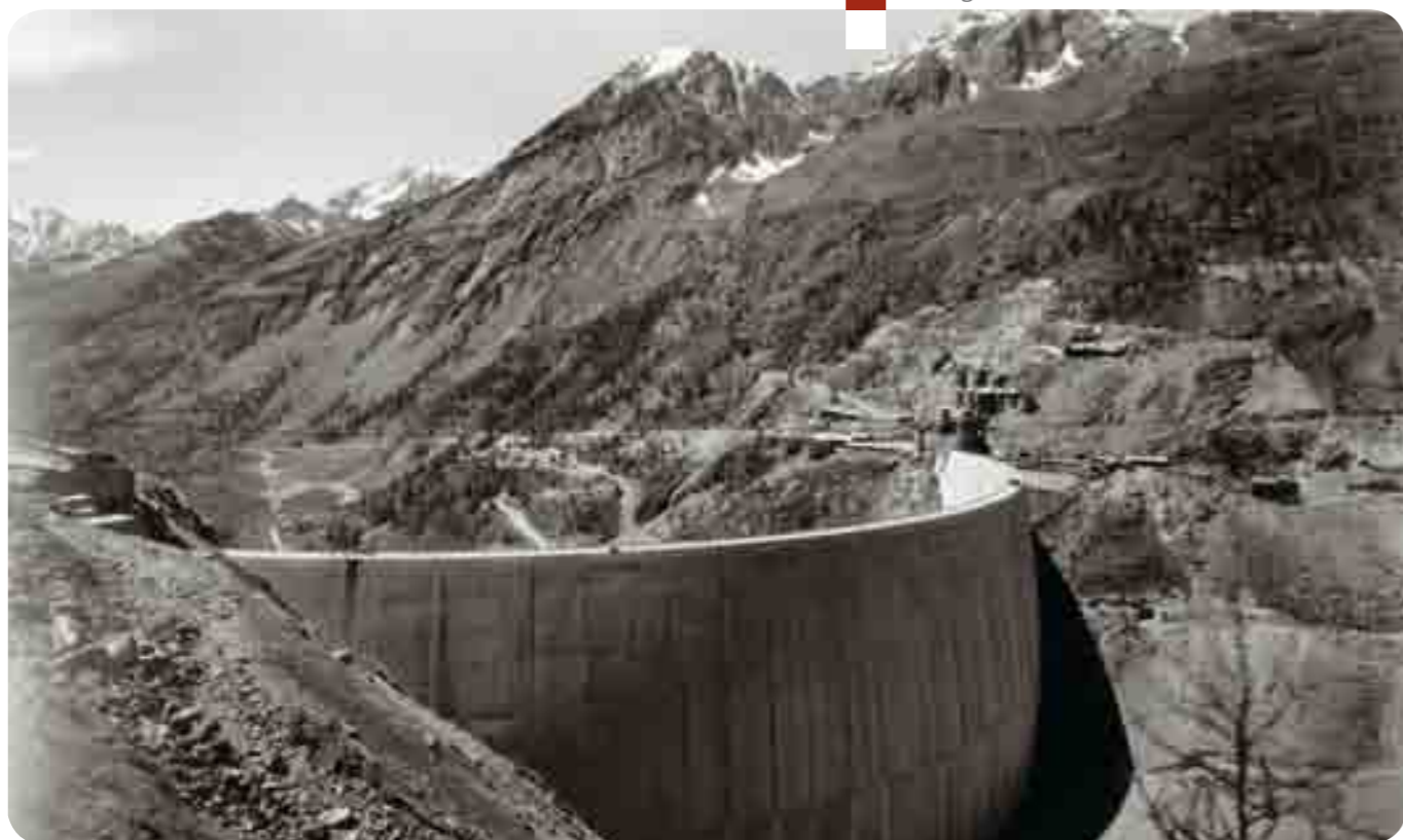
La diga di Place Moulin durante i lavori
