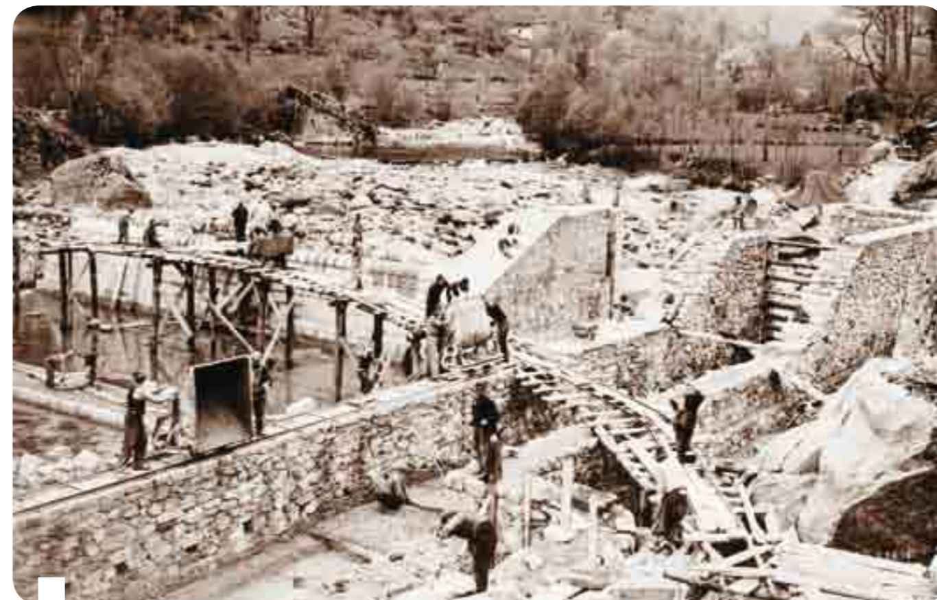
Proseguono i lavori di realizzazione del canale derivatore Rosone-Bardonetto
