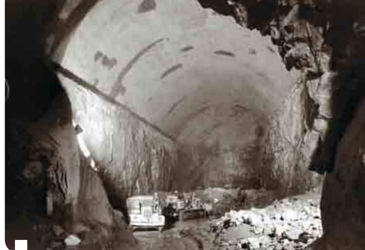
Due immagini dello scavo della centrale in caverna di Telessio
