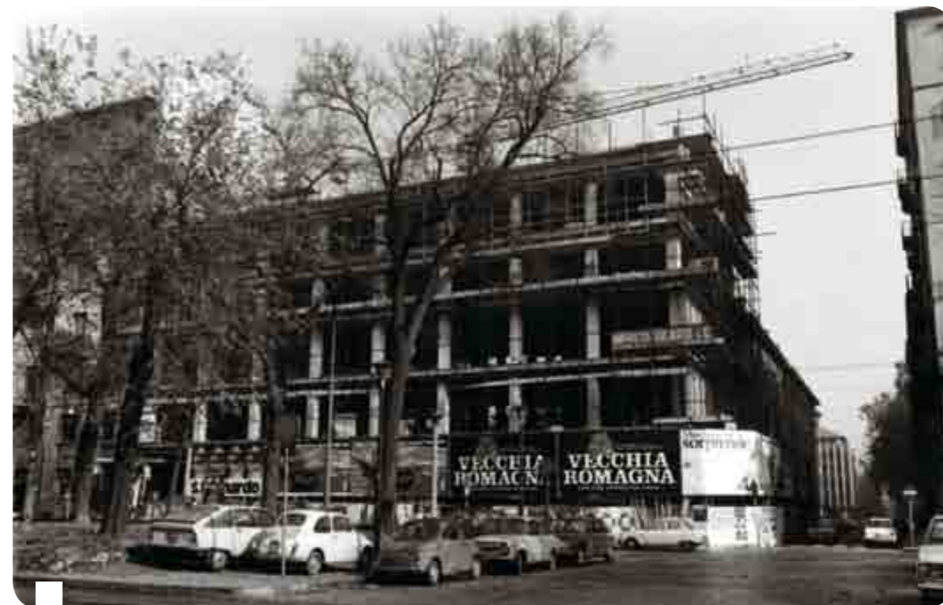
La nuova sede di via Bertola in costruzione
