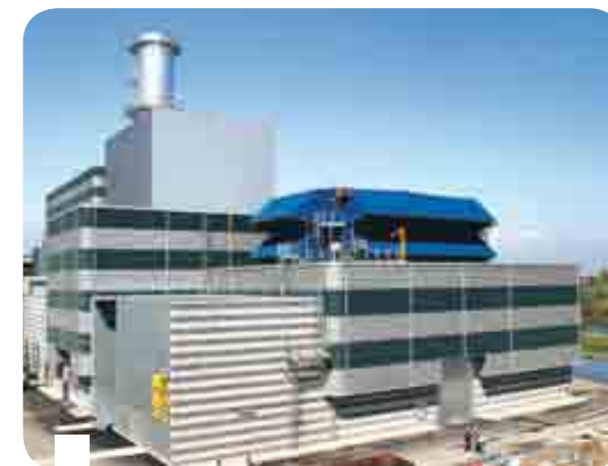
Vista dell'impianto 3° GT
