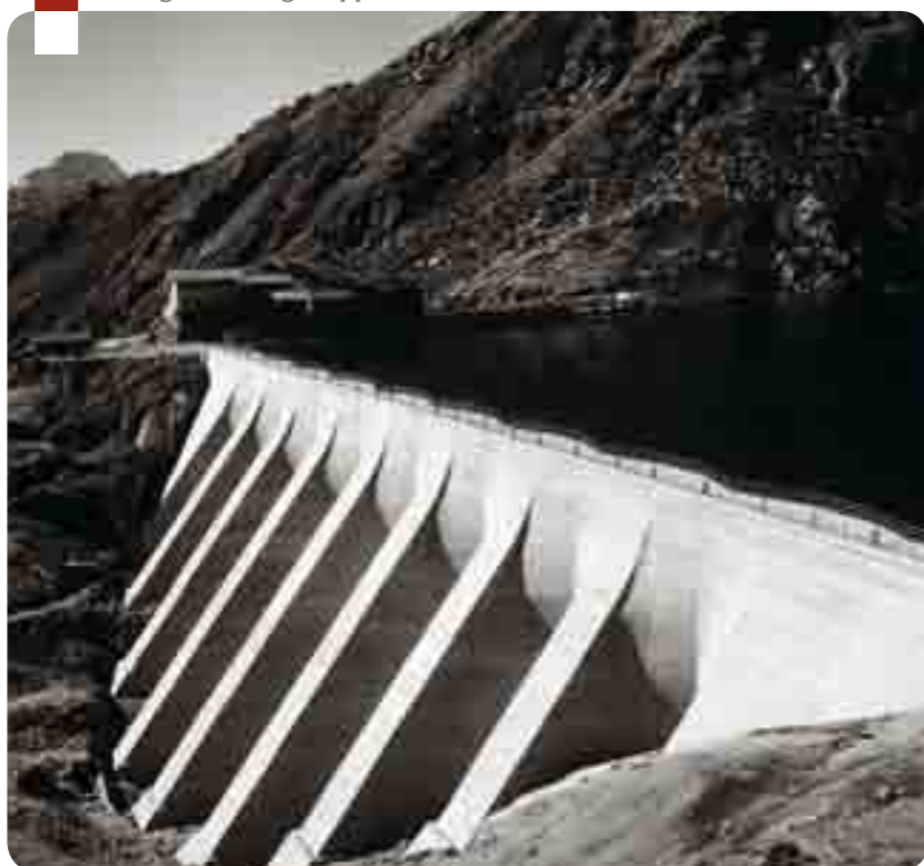
La diga dell'Eugio appena terminata
