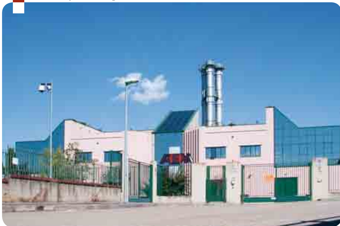
Vista dell'impianto di integrazione e riserva del BIT
