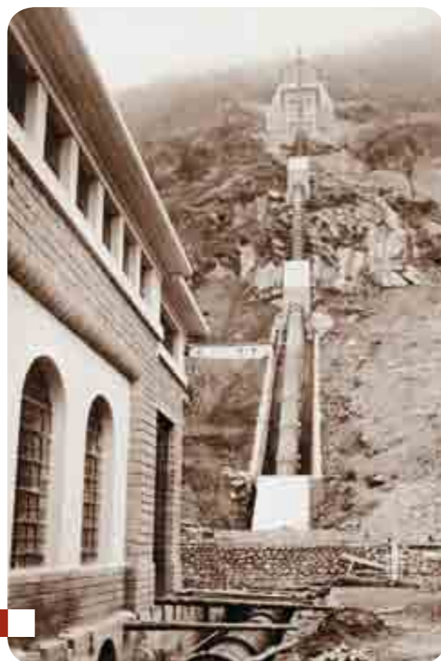
La condotta forzata della centrale di Bardonetto. In alto la camera di carico
