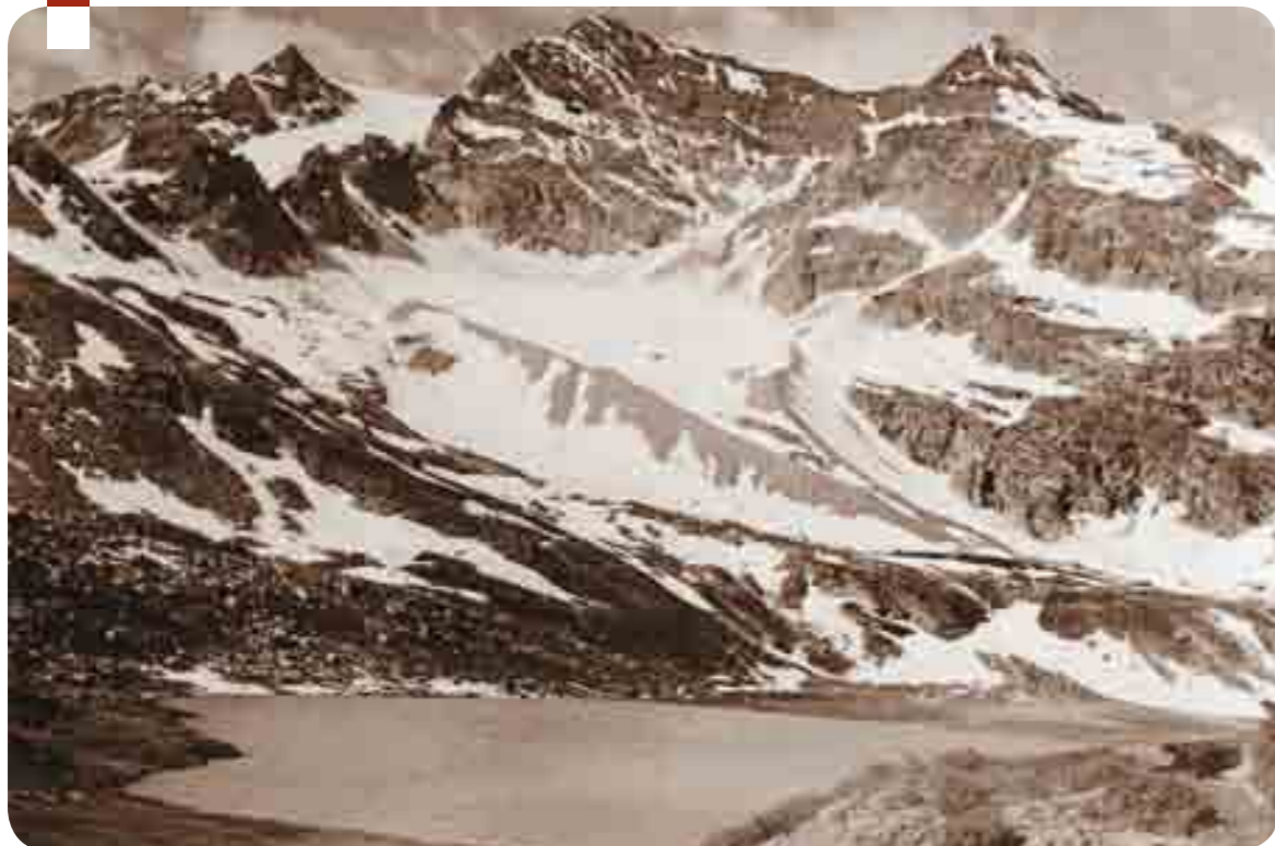
Una visione del lago del Serrù prima dell'inizio dei lavori di costruzione della diga
