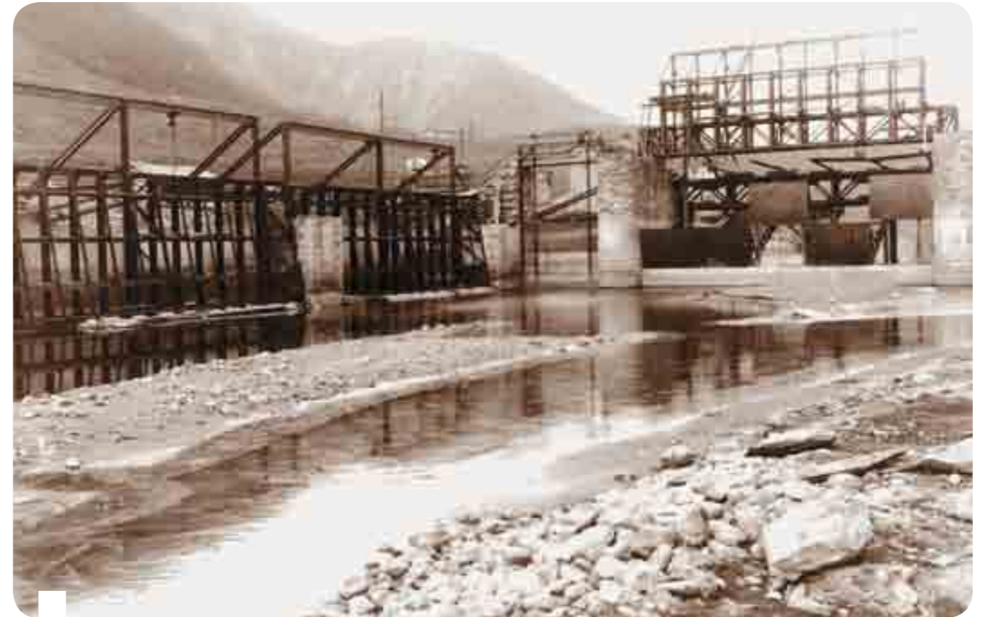
Struttura di sostegno delle griglie del canale derivatore dell'impianto Salbertrand-Chiomonte
