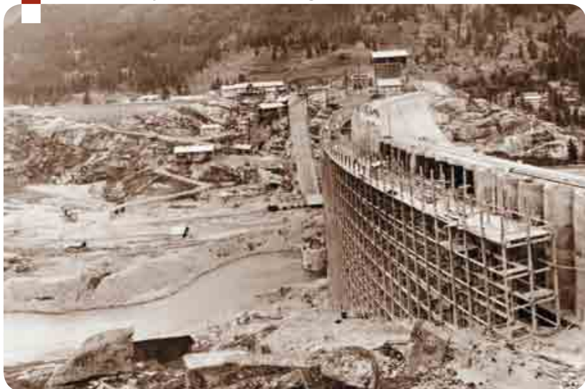
La costruzione del paramento di monte della diga di Ceresole
