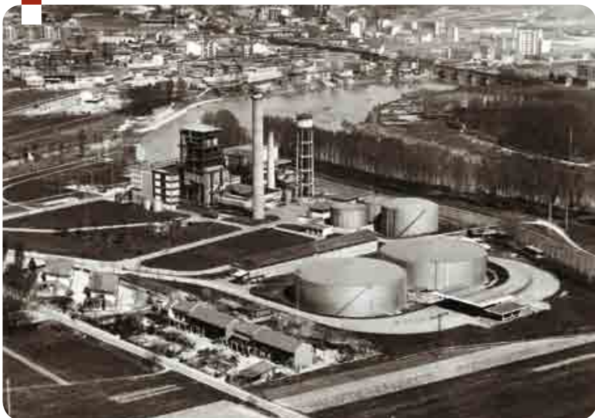
Una veduta di insieme della centrale di Moncalieri
