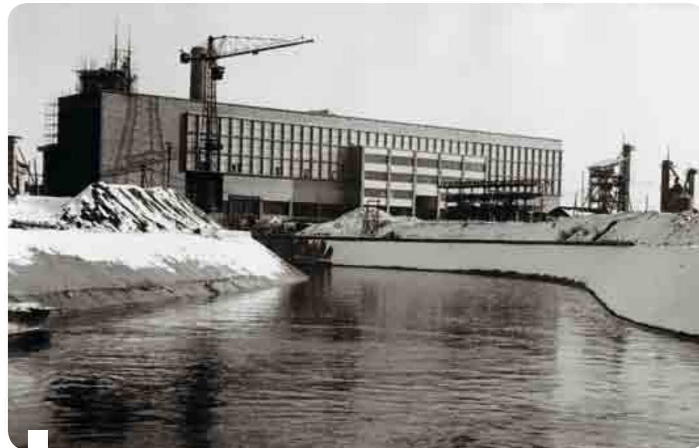
La centrale di Moncalieri in costruzione vista dal canale di scarico
