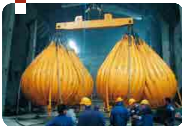
Pont Ventoux-Susa: collaudo del carro ponte nella centrale in caverna
