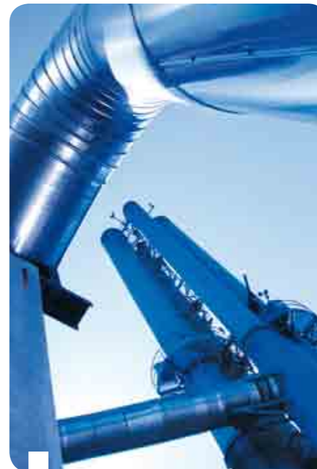
Camino della centrale Mirafiori Nord
