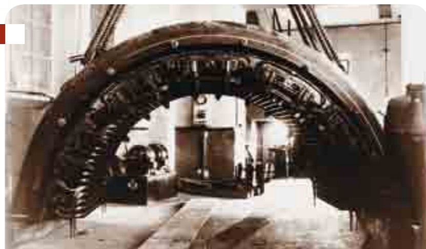
Montaggio della statore del gruppo 5 nella centrale di Chiomonte
