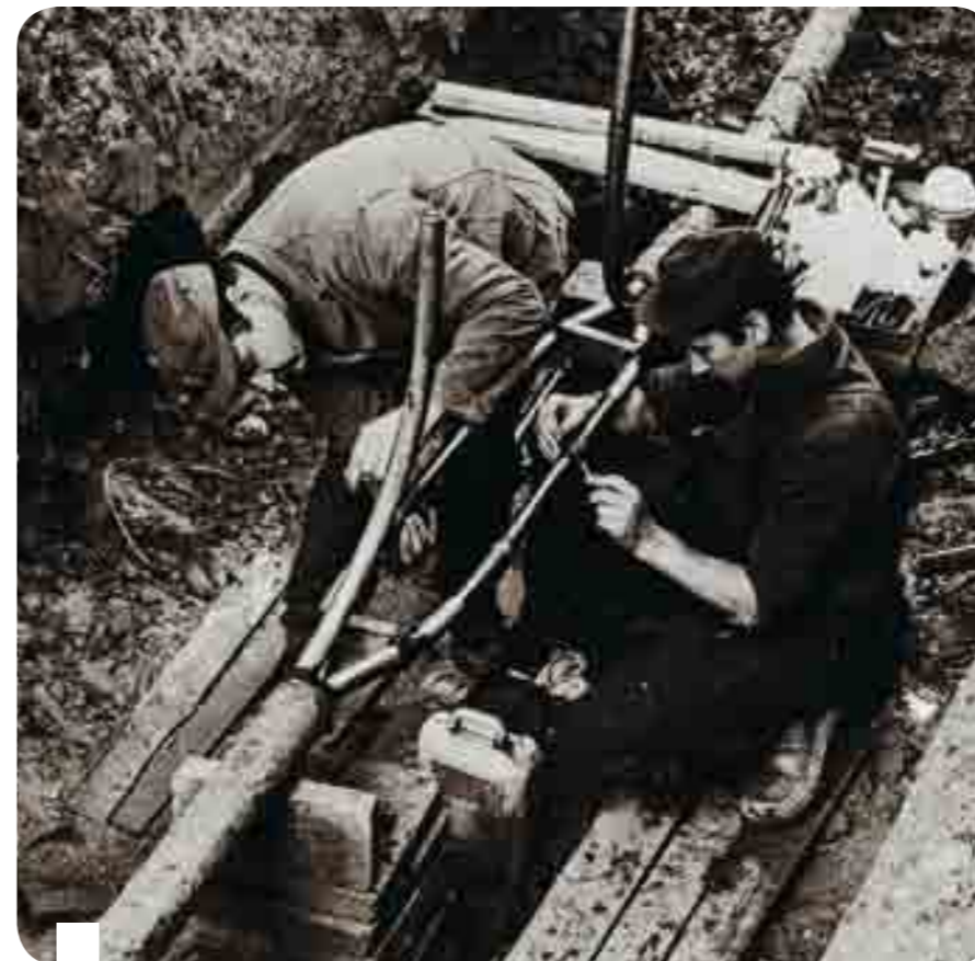
Posa di un cavo elettrico
