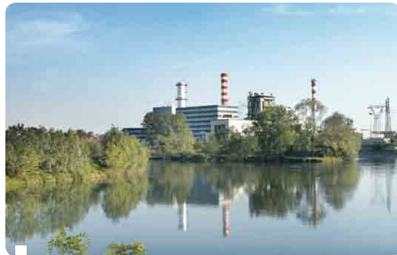
Vista della centrale di Moncalieri
