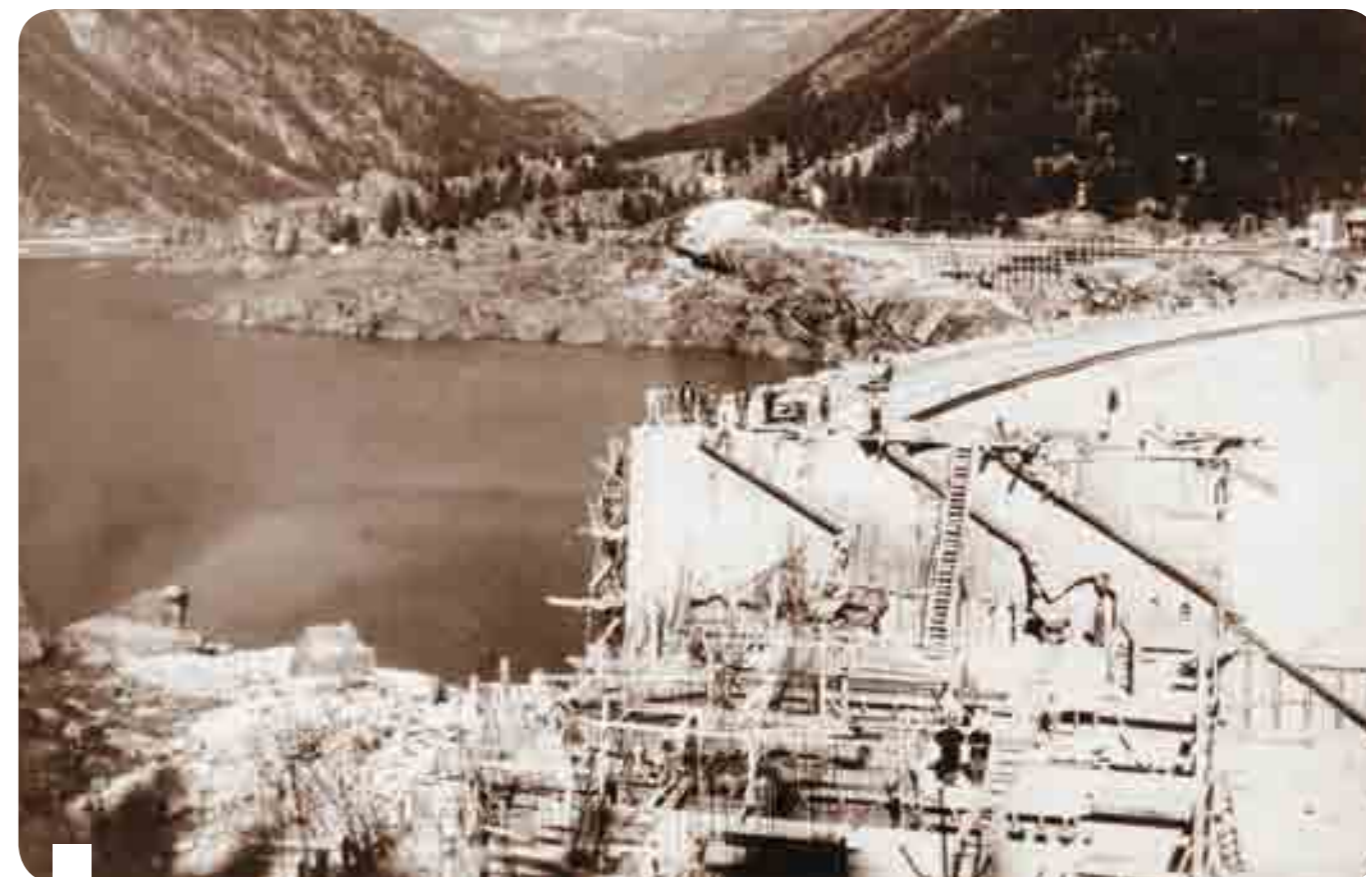
La costruzione degli autolivellatori e dalle paratoie automatiche della diga di Ceresole
