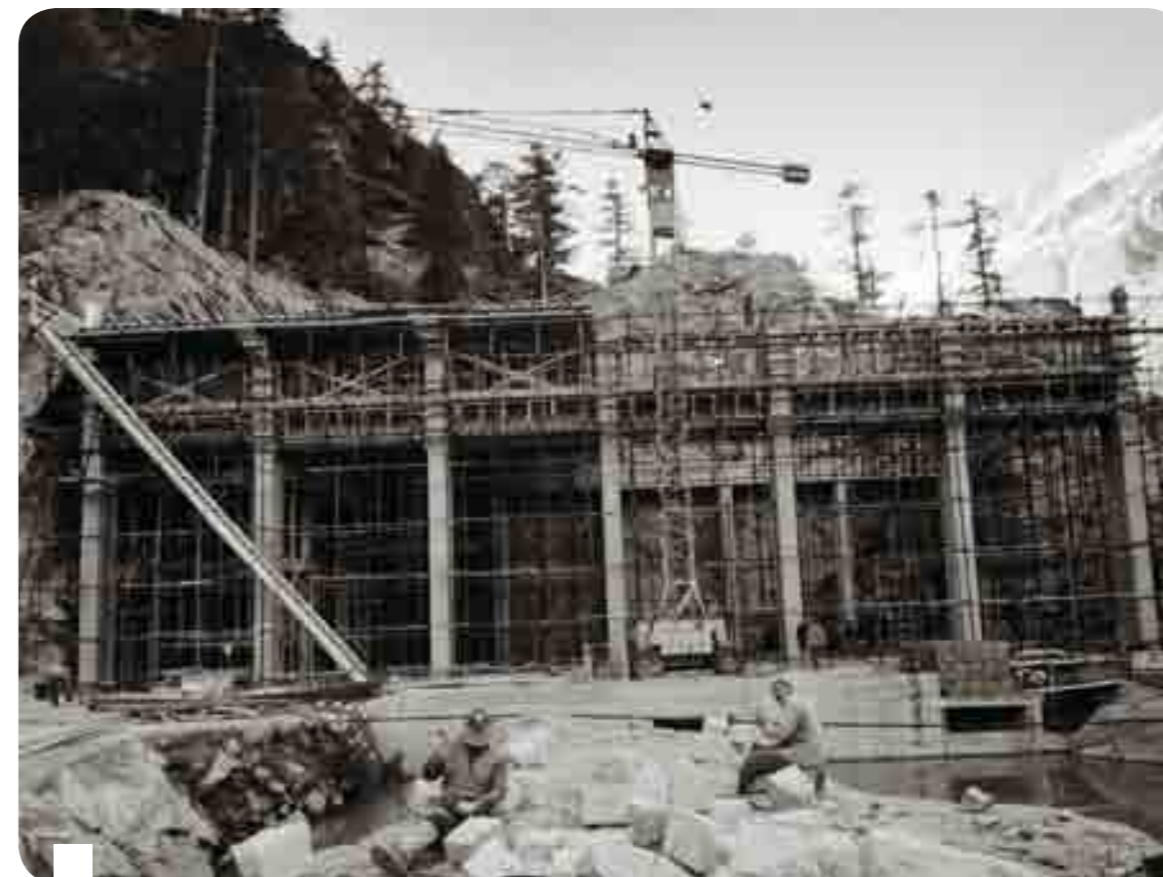
Due fasi della costruzione della centrale di Mua, poi detta di Villa
