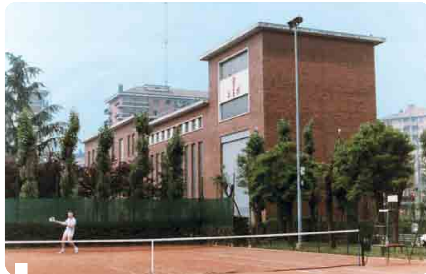
I campi da tennis adiacenti alla stazione della Sud Ovest
