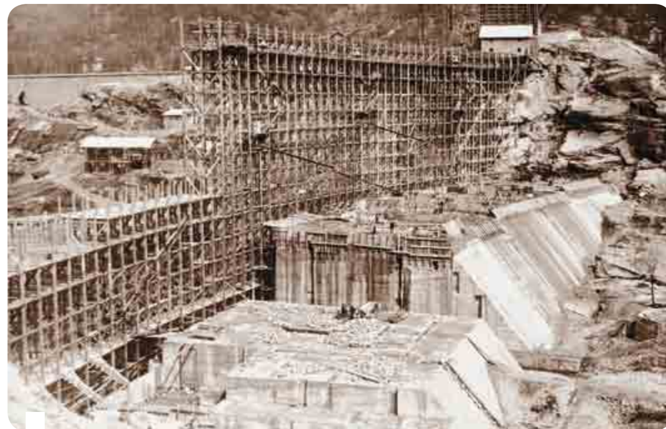
Una veduta da valle della costruzione della diga di Ceresole
