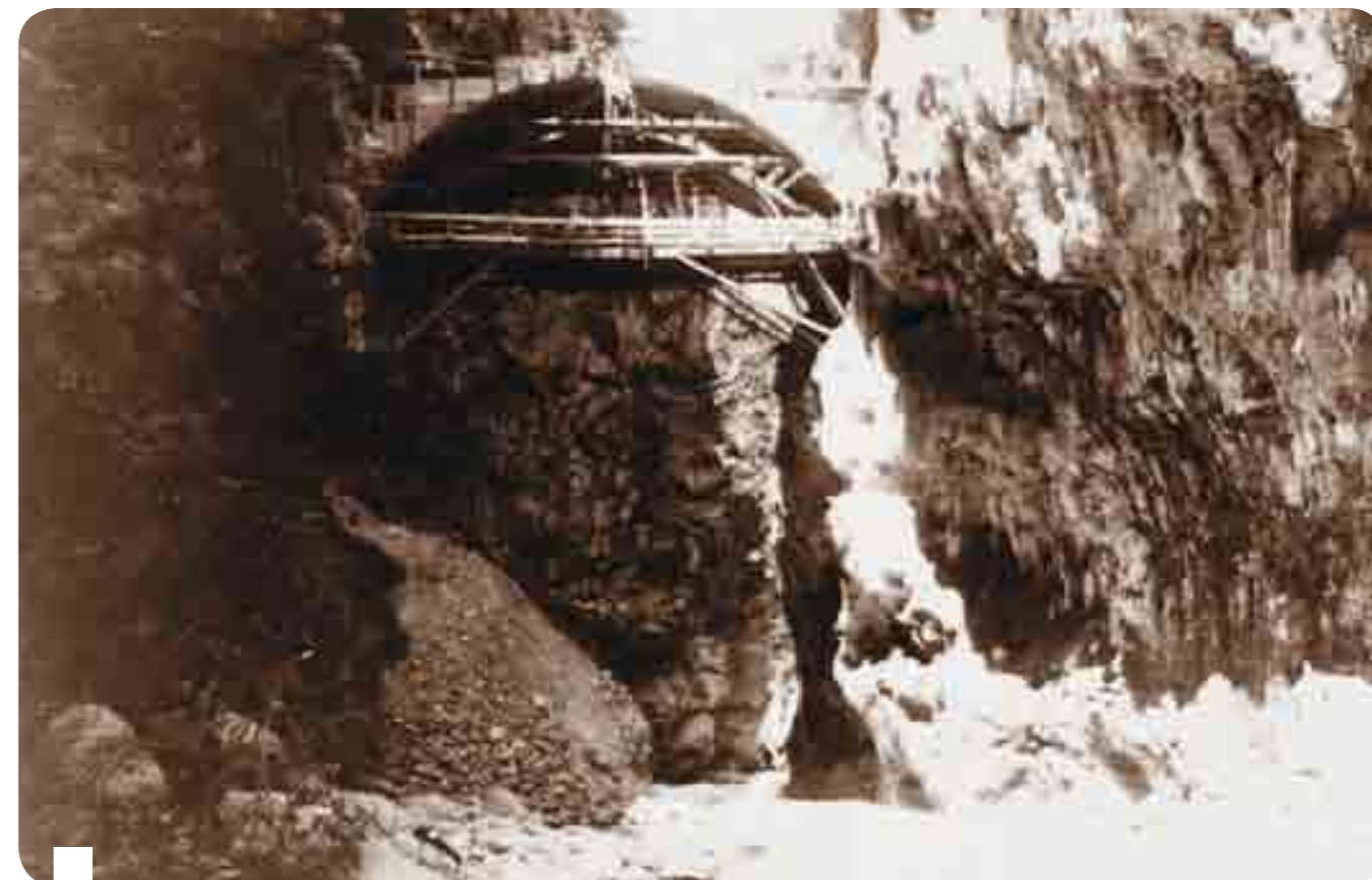
Costruzione del "Pont Canal"
