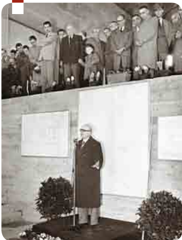
Il Sindaco di Torino, Amedeo Peyron, durante la cerimonia di inaugurazione dell'impianto idroelettrico Po-Stura-San Mauro
