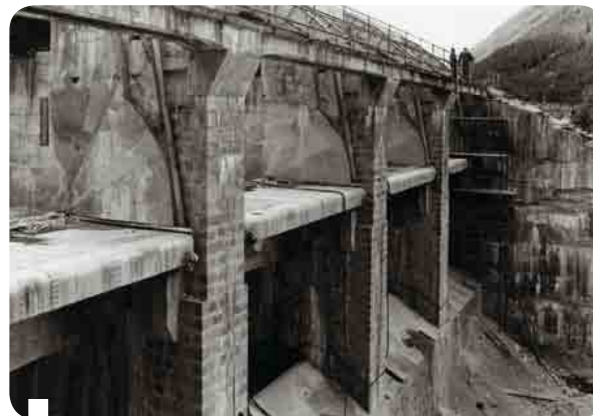
Due fasi del rifacimento degli sfioratori della diga di Ceresole
